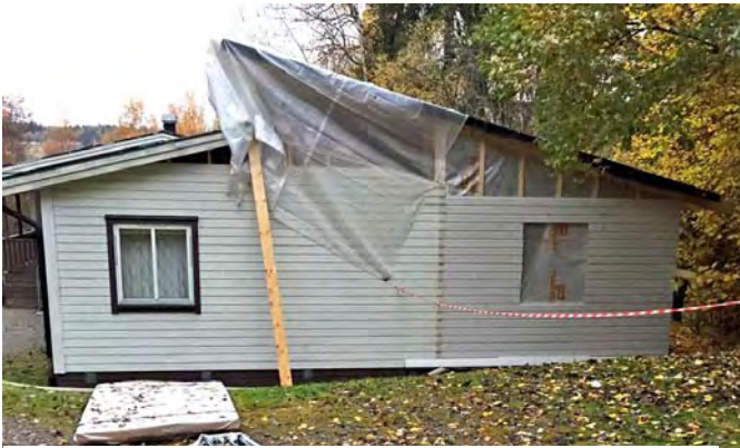
24 okt - Plasten ska hindra regnet
